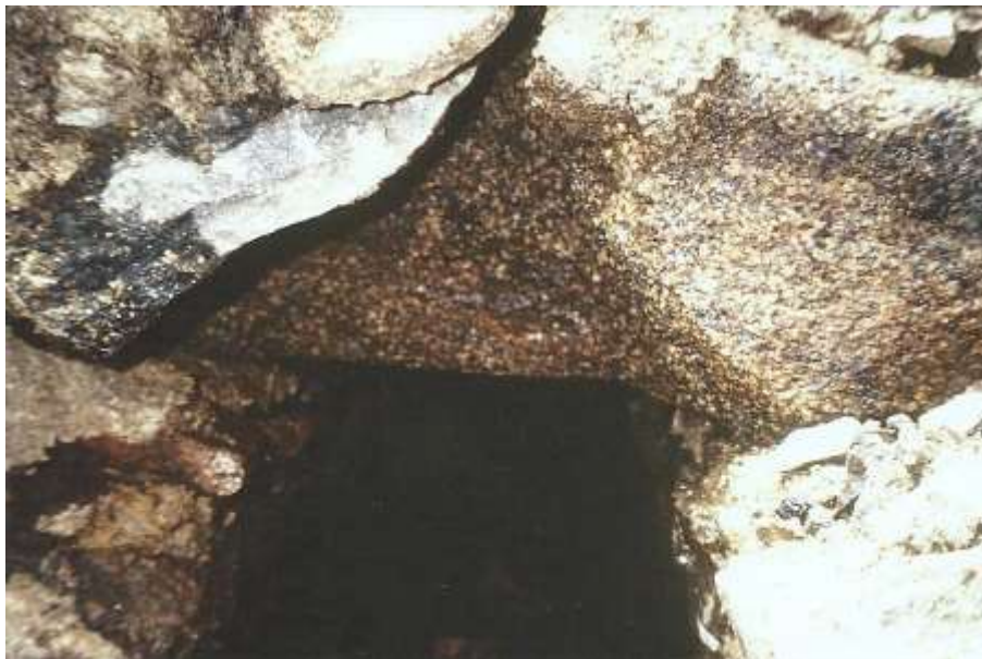
Réseau ouest-est : arrivée de l'ouvrage dans la cheminée d'accès en couverture voûtée.
