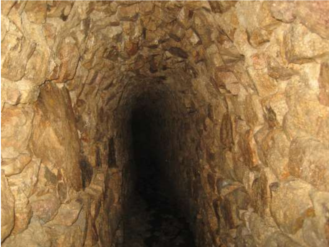
Vue de l'aqueduc vers le sud-est : largeur 0,70 m.
