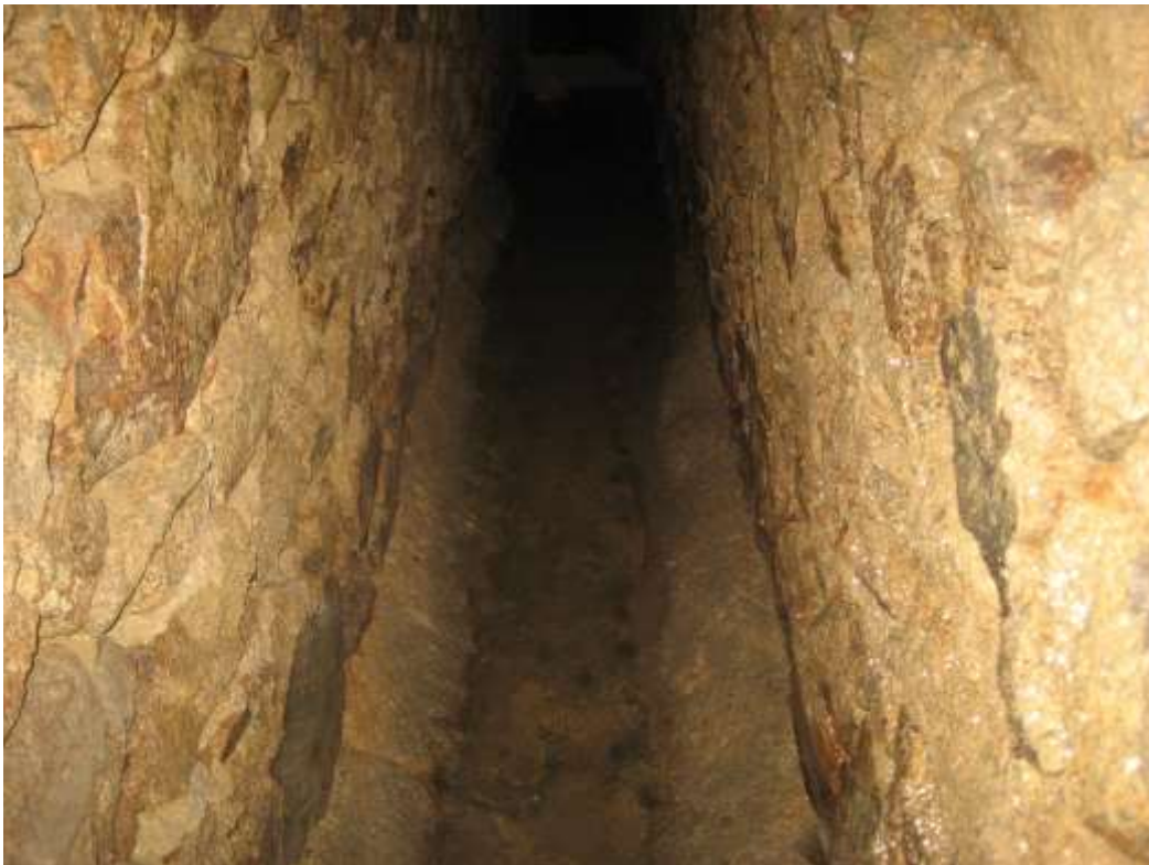
Le canal est creusé dans la roche, le parement repose directement sur la banquette, on n'observe pas de mortier d'étanchéité au tuileau.
