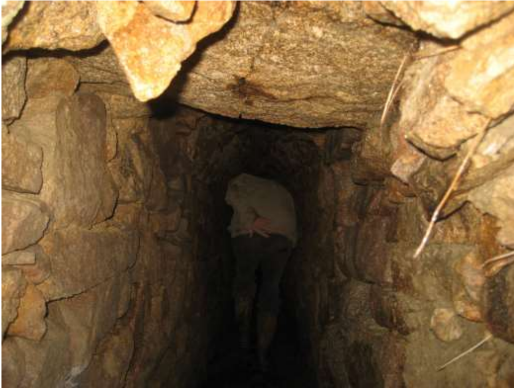
Réduction de la hauteur sous voûte après le passage de la cheminée n°2.
