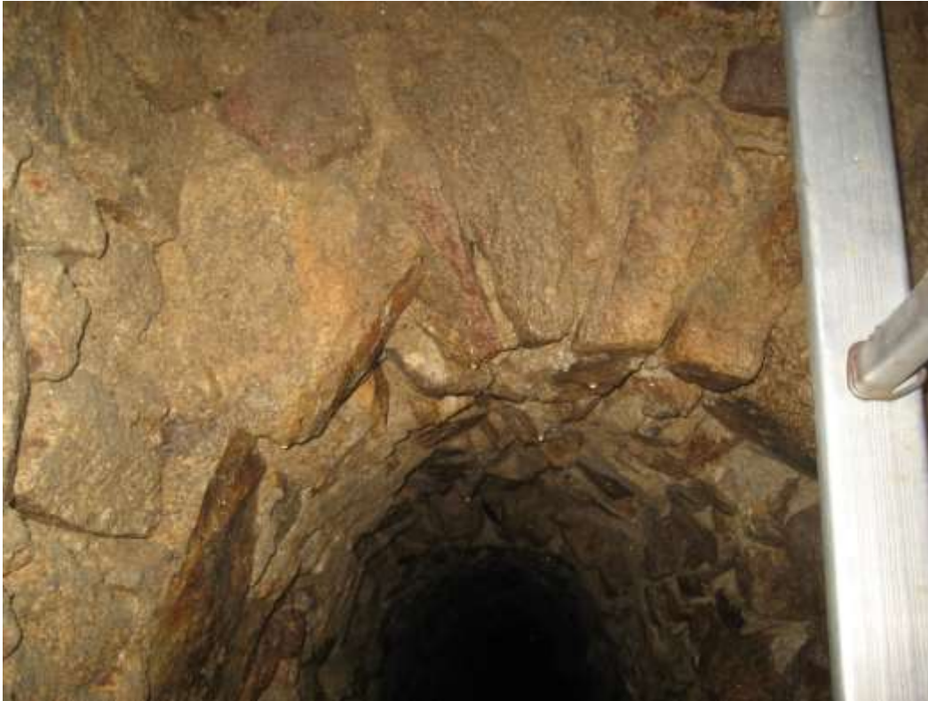
Base de la cheminée d'accès, hauteur sous voûte 1,80.m
