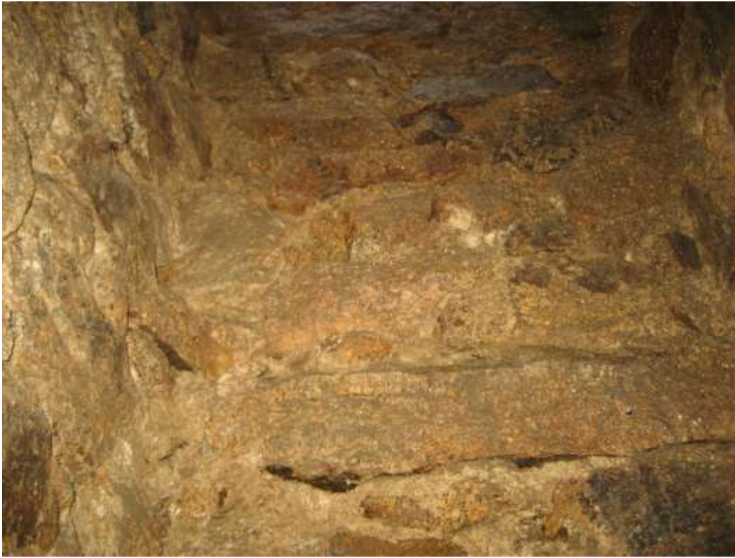
Cheminée n°3 vue du fond de l'ouvrage.
