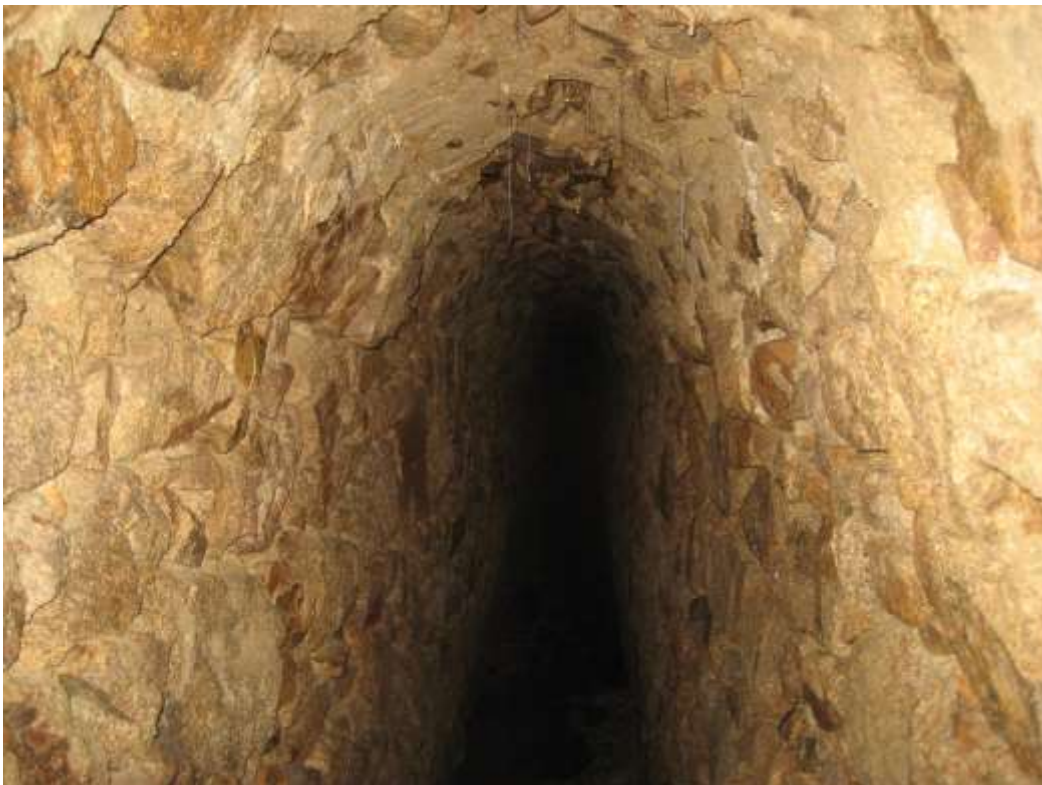
Traces de planches de coffrage sur la voûte.
