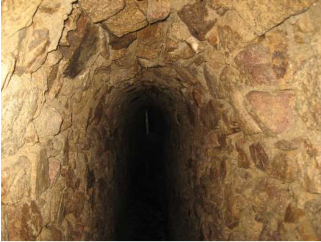
Visite de la partie nord-ouest après la cheminée d'accès n° 1
