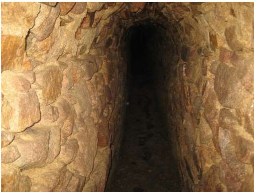
Réduction de largeur de l'ouvrage (peut-être en raison d'une dureté plus forte de la roche).
