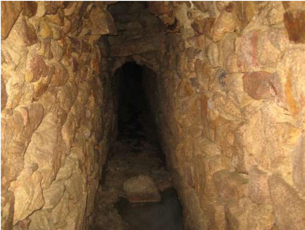
Arrivée sur la cheminée n°2.
