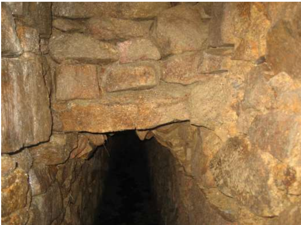
Base de la cheminée n°2 présentant une possible restauration.
