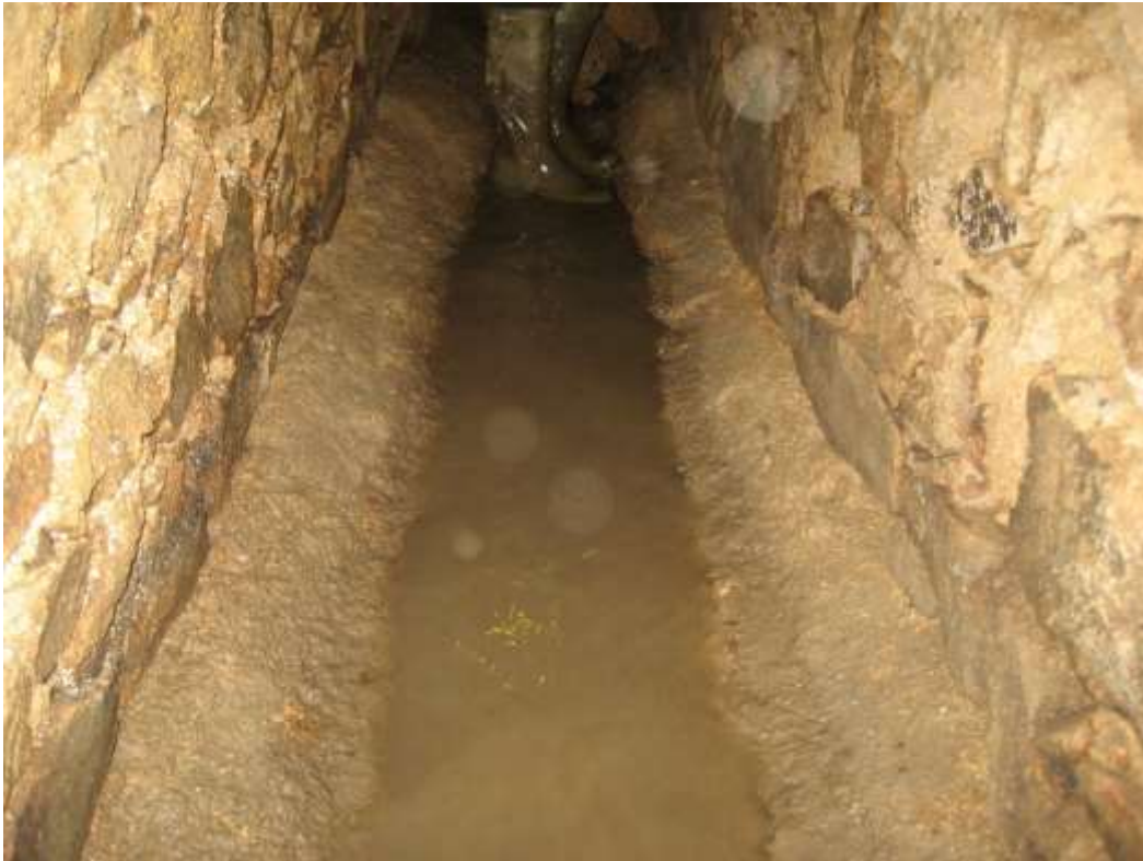
Dimension de la cunette 0,30m., dimension des barquettes 0,20m.
