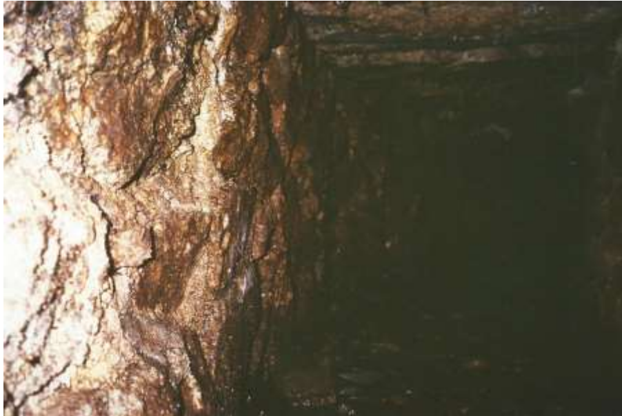
Descente dans une cheminée d'accès à l'intersection de deux réseaux : réseau sud-nord départ de l'ouvrage réalisé par une couverture de dalles disposées horizontalement
