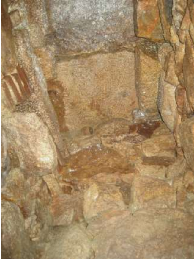
Vue depuis le fond de la fermeture de la cheminée n°2. On note la présence de carreaux de brique.
