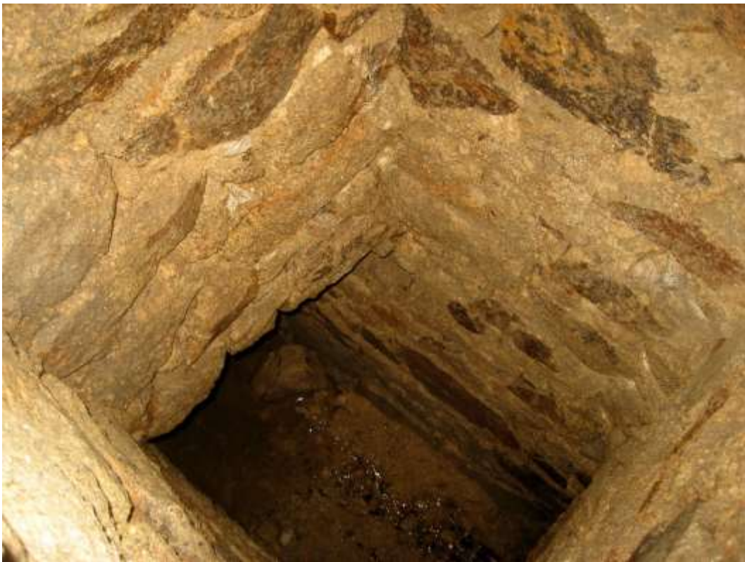
Dimensions de la cheminée vue de la surface : 0,60m.x 0,60m. X 1,63m.
