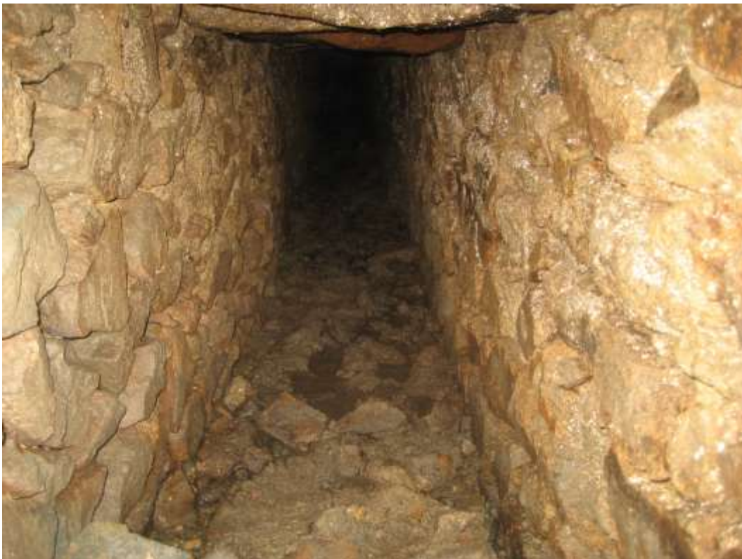
Changement de construction de l'ouvrage : passage de la couverture en voûte, en dalles horizontales.
